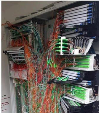
Illustrations de dysfonctionnements liés au mode « Stoc » (source : Avicca)
